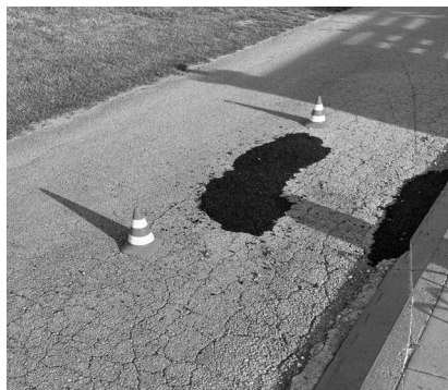
Oprava zničeného asfaltu, Lukáš Marek
